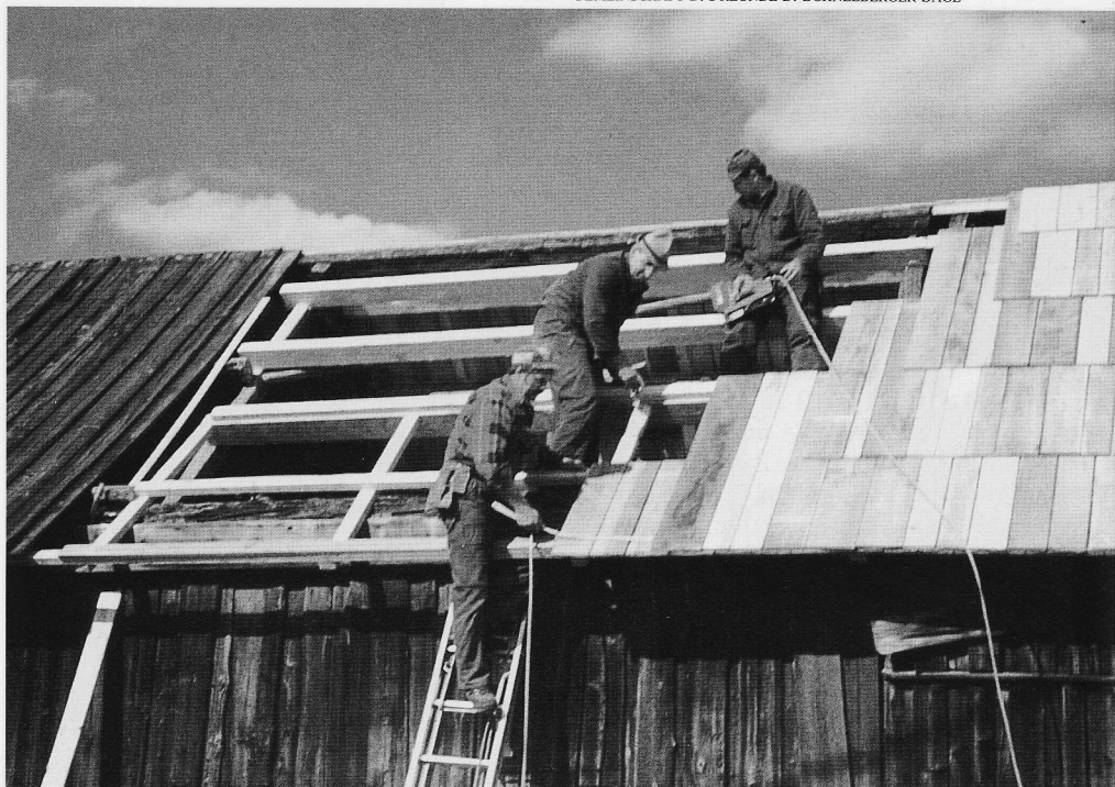
Freiwillige Helfer beim Eindecken des Kurzbretterdaches: Arbeit nach den Jahreszeiten
